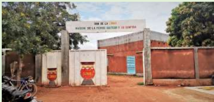
Photo 1: Portique de la Maison de la Femme de Banfora, site de la formation
